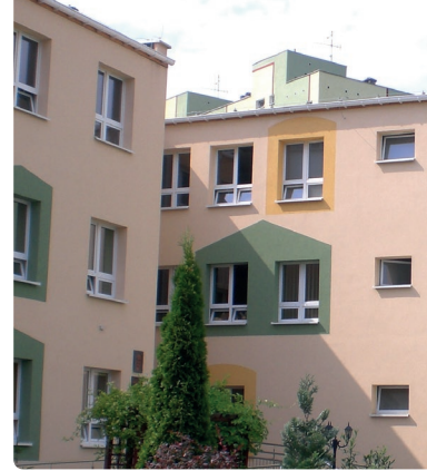
WS-SPZOZ Zgorzelec, Ośrodek Rehabilitacji
